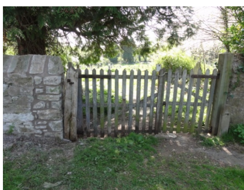
Atgyweirio waliau wrth giât y gogledd.
